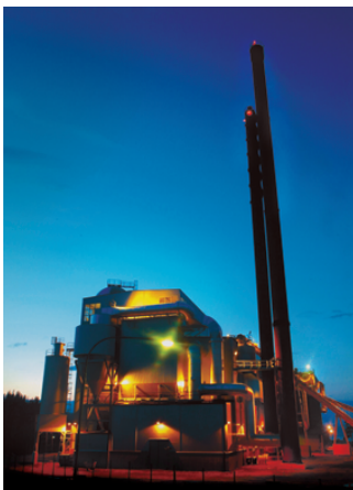
Kraftvärmeverket gör de nya elcertifikatsavgifterna billigare.
